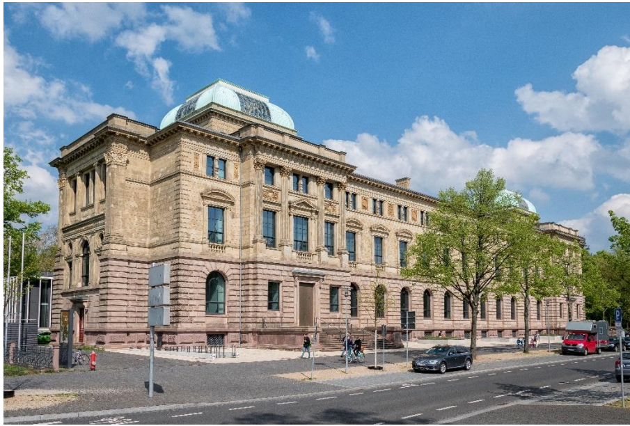
Abbildung 13: Außenfassade des Herzog Anton Ulrich-Museums (Quelle: Claus Cordes)
